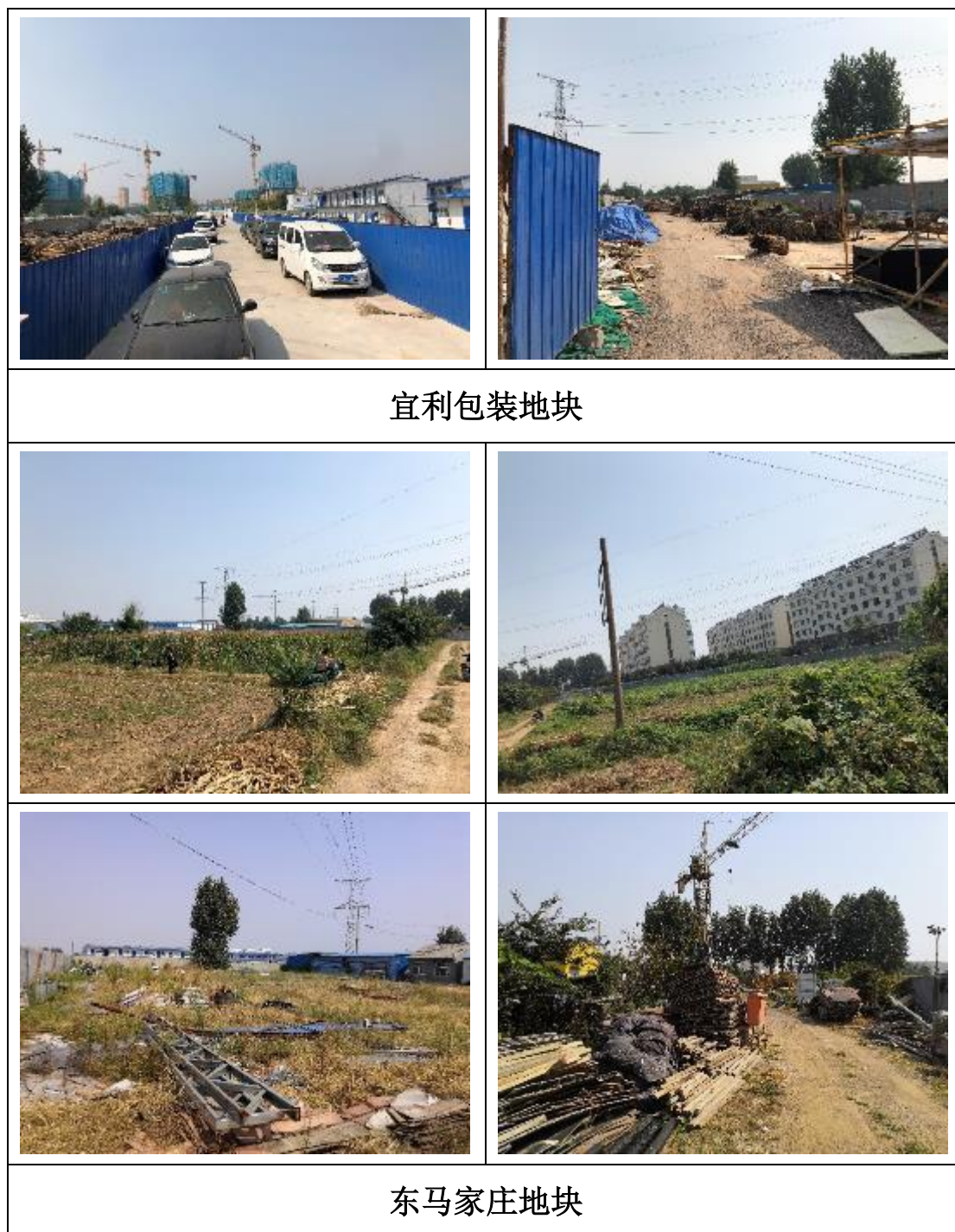
图 3-4 现场踏勘照片
